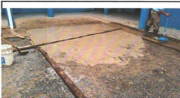
Foto 2: colocacion de losa de patio
